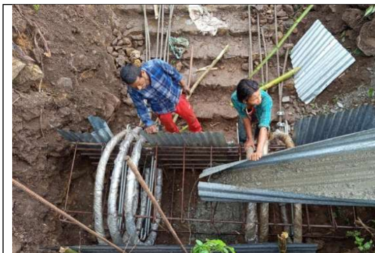
राप्ति नपा - १२ मा निर्माणाधिन वाकाड पखाल भोलुङ्गे पुल(D-type)
